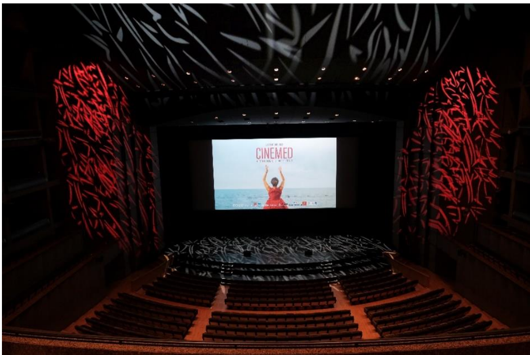
Nouveaux éclairages LED de l'auditorium Berlioz au Corum_Crédits photos Montpellier Events
