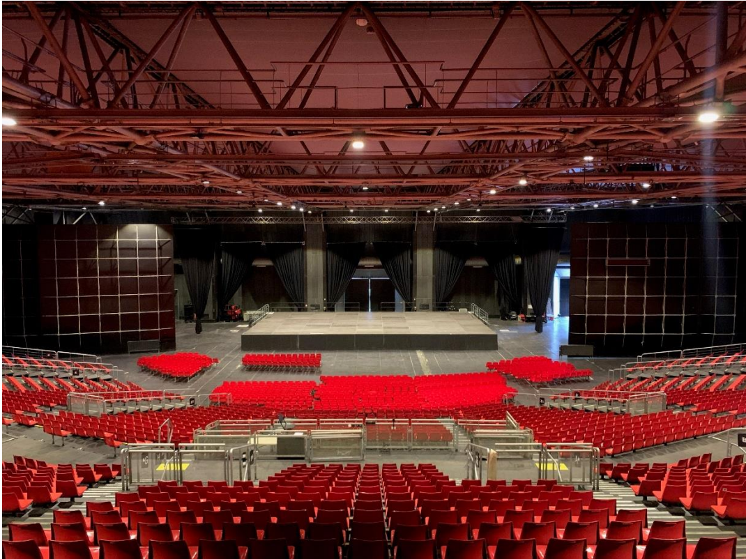
Nouveaux éclairages LED de la salle de spectacles du Zénith Sud_Crédits photos Montpellier Events
